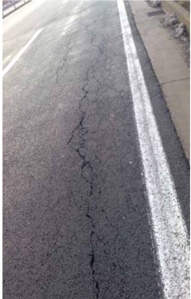
Slika 6. Oštećenje asfaltnog sloja kolničke konstrukcije tipa pukotina nastalih kao posljedica loše otpornosti asfalta prema niskim temperaturama
