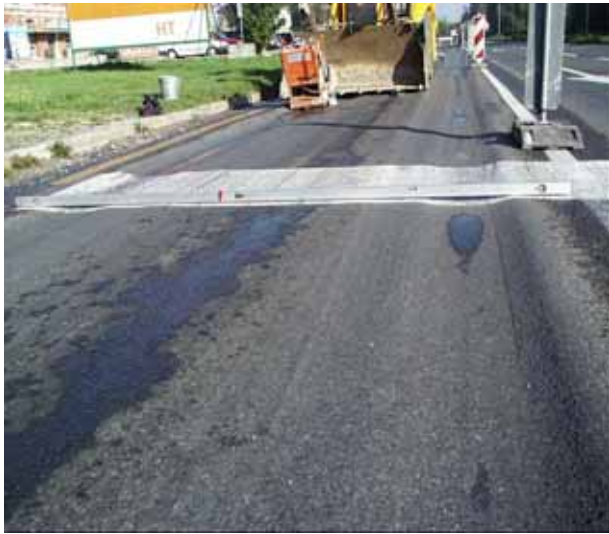
Slika 5. Oštećenje asfaltnog sloja kolničke konstrukcije tipa kolotruga
